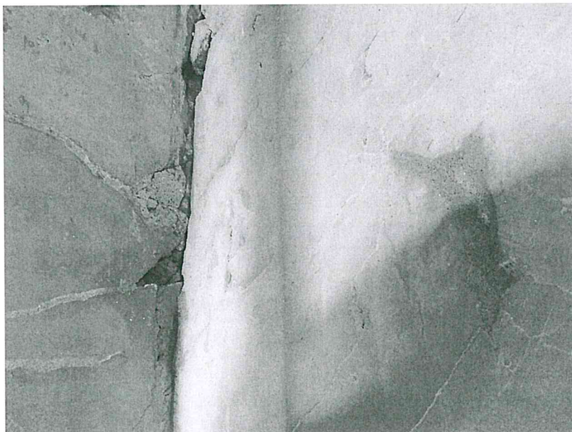
Distacchi di intonaco antico nell'angolo tra la parete sud e la parete est (ove si apre la porta d'ingresso alla casa)
