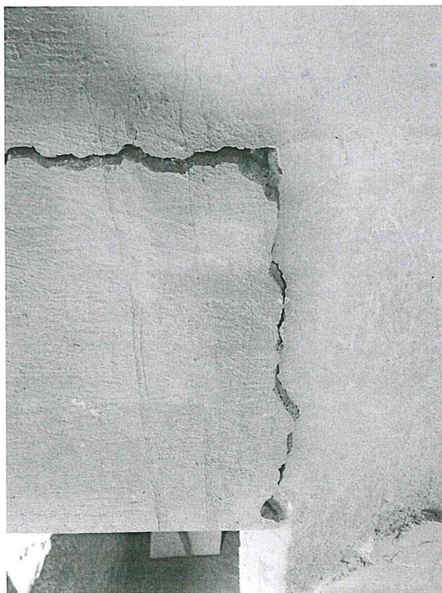
Intonaco novecentesco su architrave in pericolo di crollo
