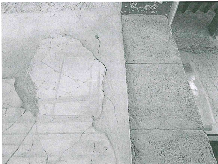
Lesioni sull'intonaco moderno-parete sud
