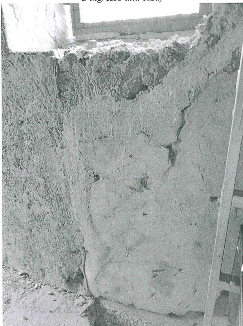
Distacchi di intonaco antico lungo la parete est
