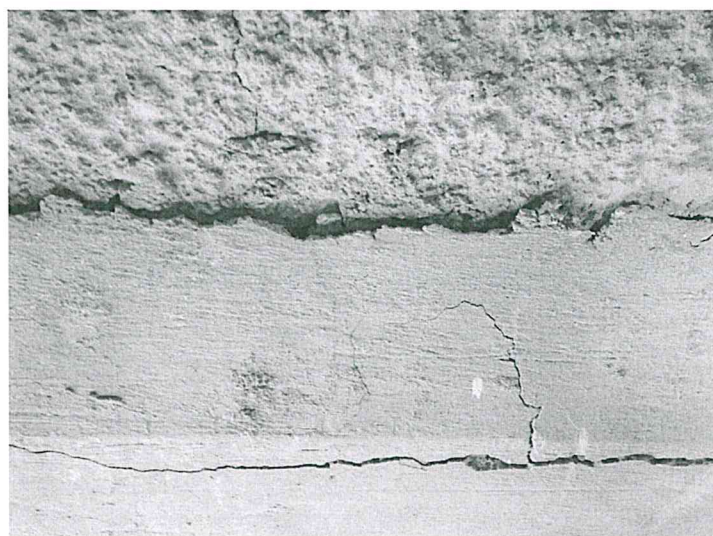
Particolare distacchi intonaco moderno sull'architrave
